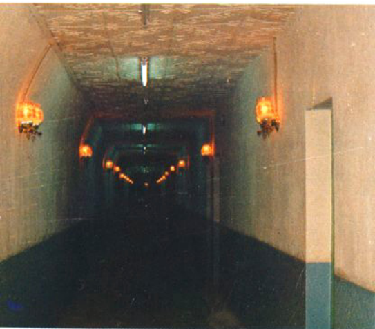
人防工程通道
