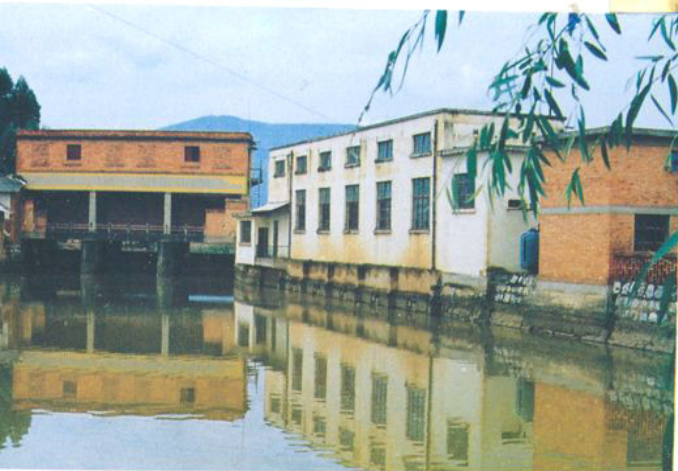
洪家村抽水站及水闸
