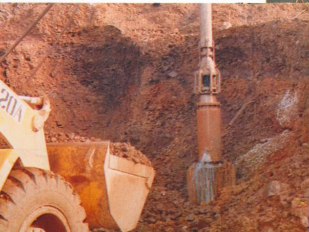
↓ 振冲技术加固后坝坡
