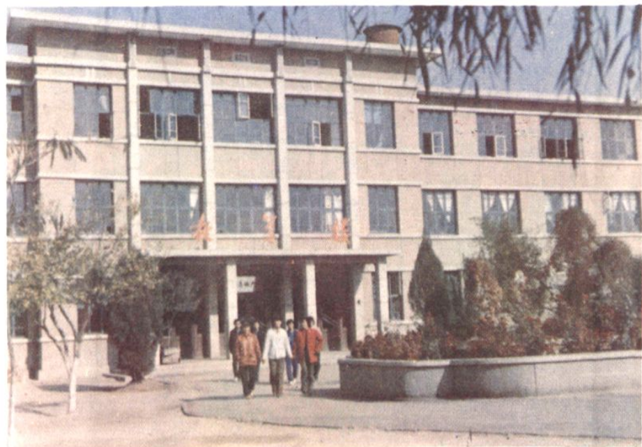
丰润县城关中学教学楼
