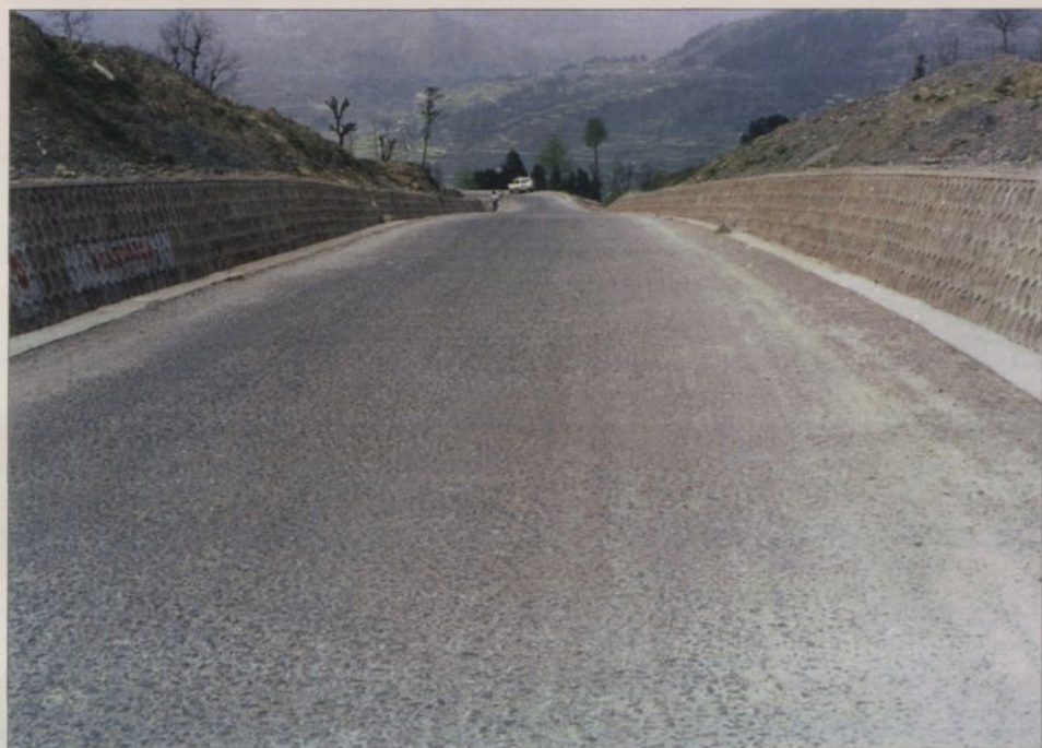
石阡至镇远上龙关段平直 整洁的公路
