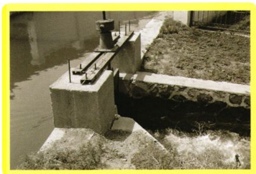
西峪水库干渠出水口
