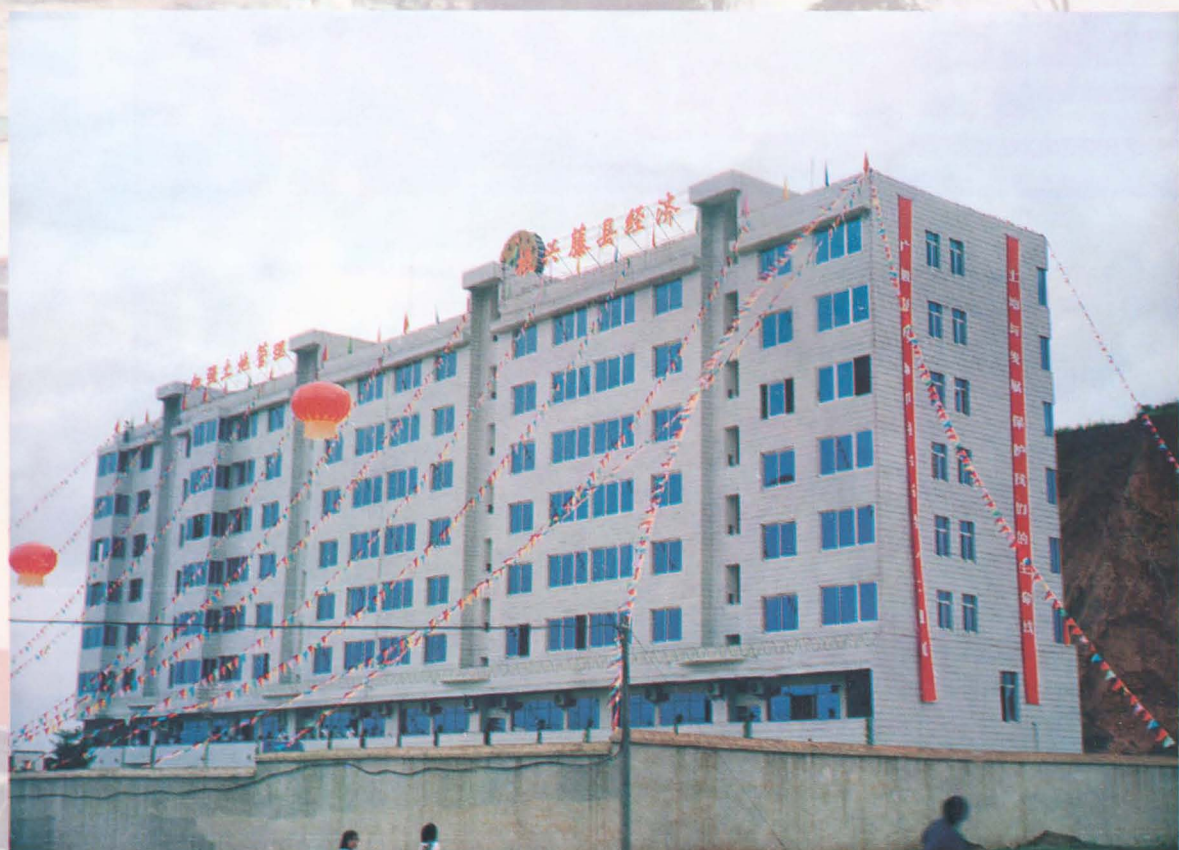
位于河东新城区,投资 456.6 万元,建筑面积 6546 平方米的办公、住宅综合楼。
