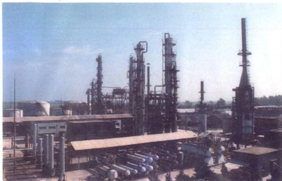
年加工量15万吨两套常减压蒸馏装置。
