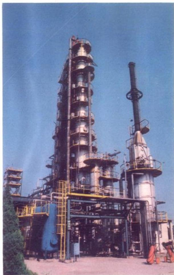
年加工量4万吨同轴式催化裂化装置。
