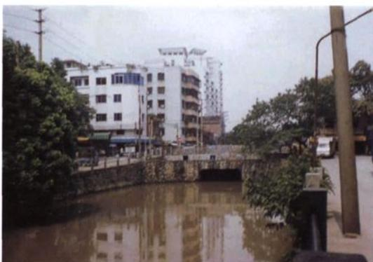
1958年筑防洪堤，堵了脉沥洲河河口，逐渐淤塞。2000年大部分河段盖上海泥，成为暗渠，仅余珊洲桥以下几十米河面。（谭少芳 摄）
