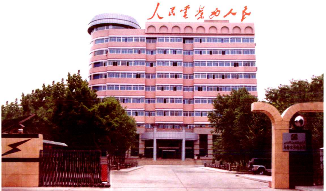
乌鲁木齐电业局生产用电网络中心楼
