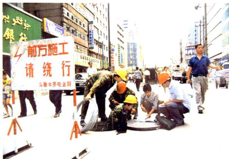
中山路配网改造——铺设电缆
