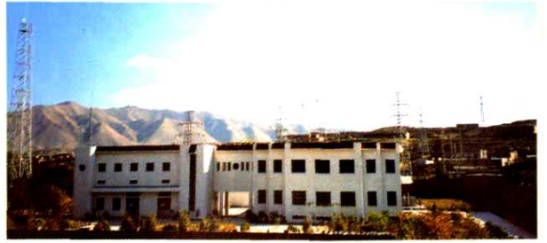
110 千伏西山变电所
