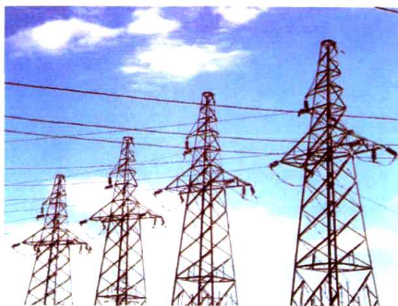
1960年建成的新疆第一条110千伏输电线路——钢(铁厂)-昌(吉)线
