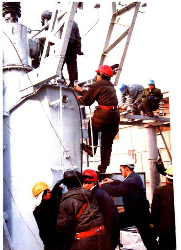
主变压器检修
