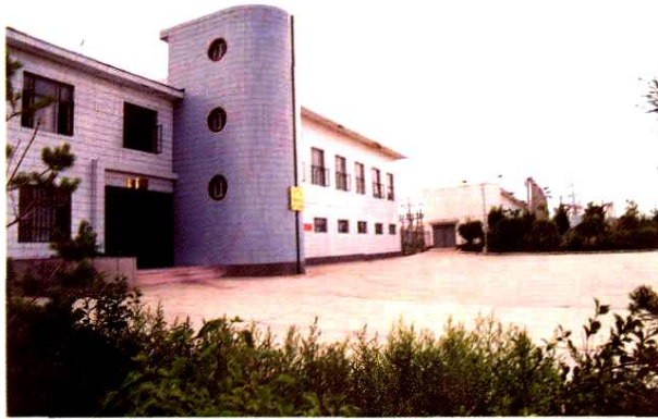
220 千伏头屯河变电所
