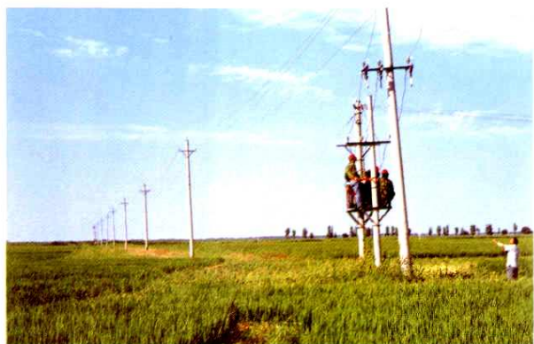
农电设备检修
