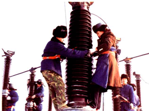
变电设备检修
