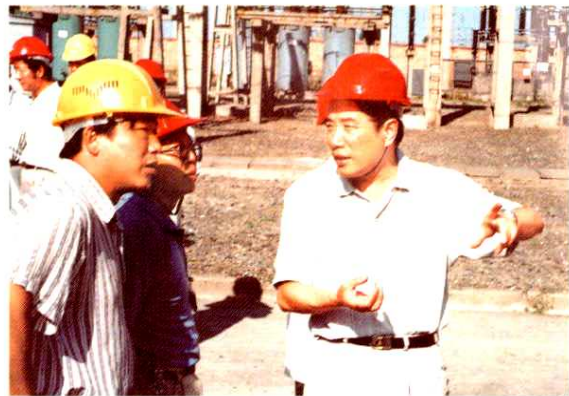
西北电业管理局局长丁中智(右)在变电所建设工地与职工交谈。
