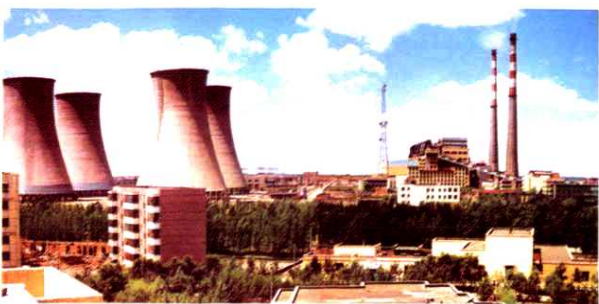
装机容量最大的火力发电厂——玛纳斯电厂
