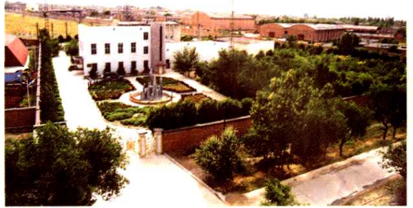
110 千伏铁西变电所
