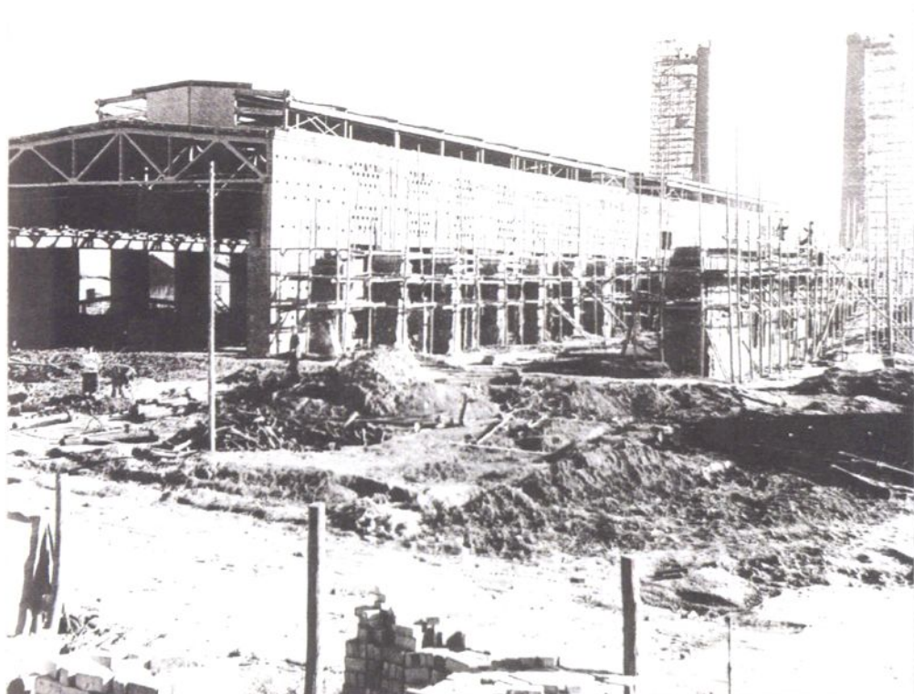
建设中的小型轧钢车间 (1953)
