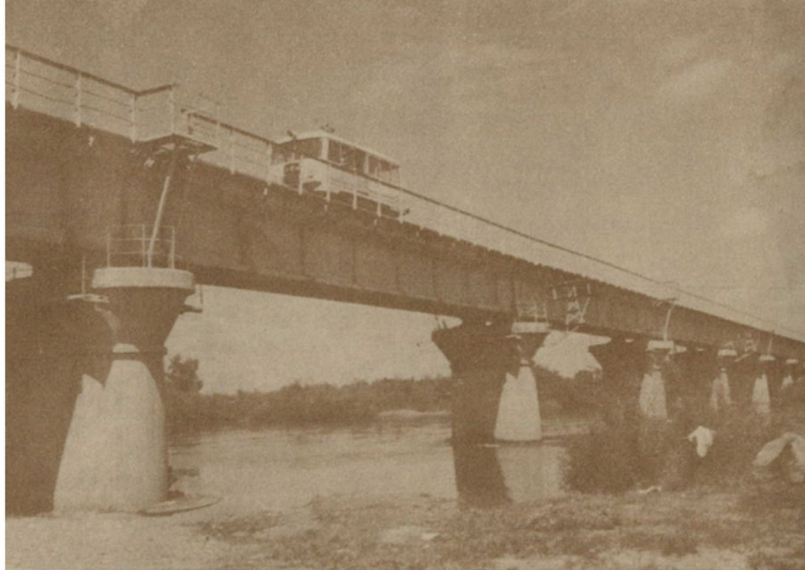
大杨树煤矿铁路专用线大桥
