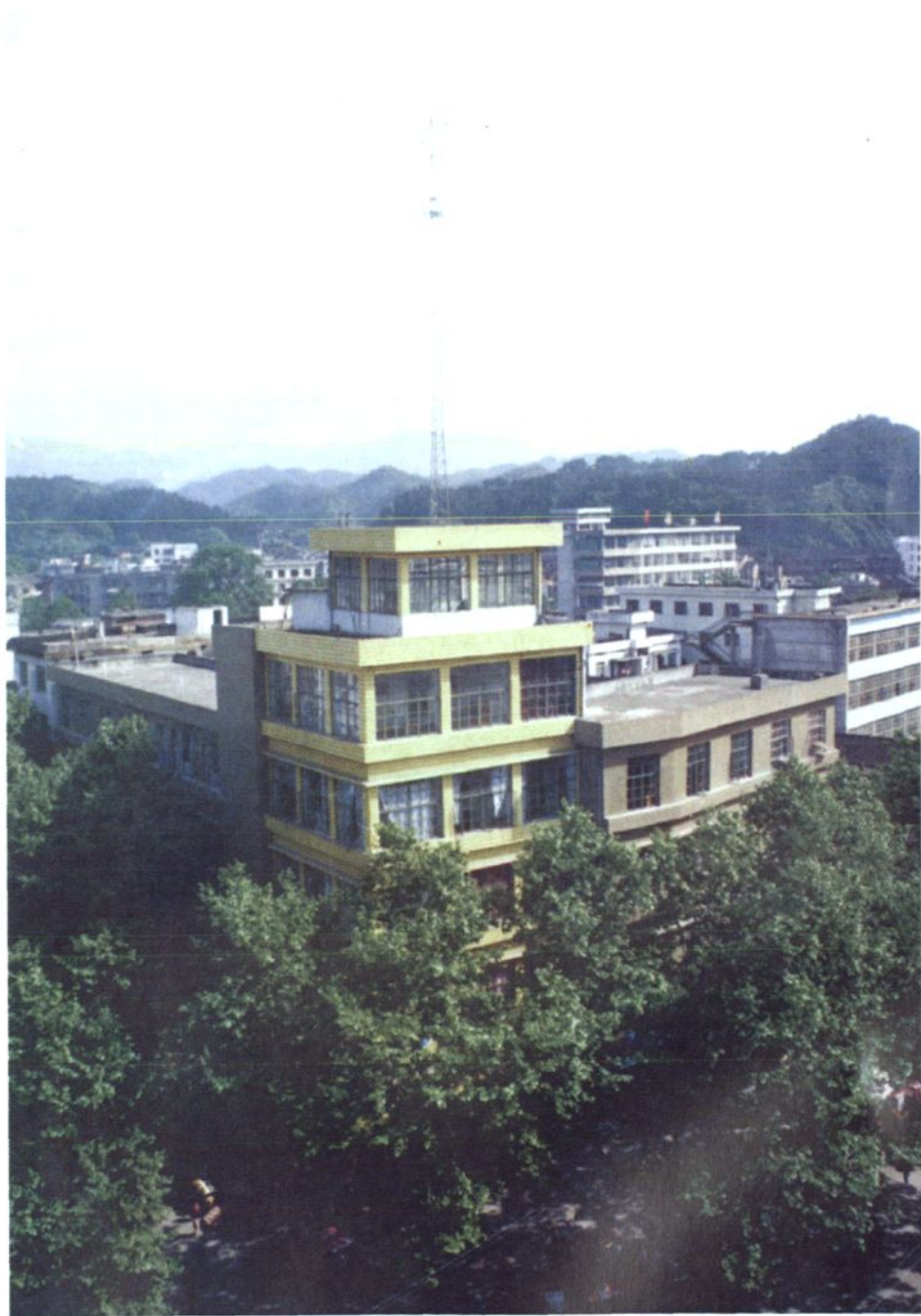
铜鼓县邮电大楼外貌
