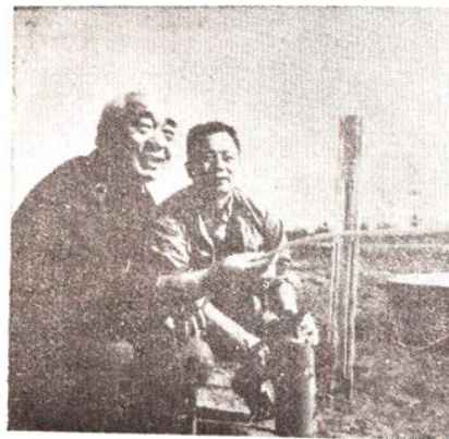
仓子和同志（左）在建池现场
