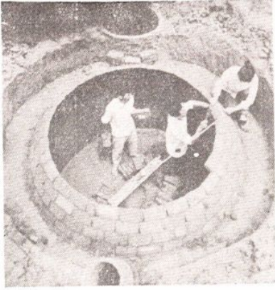
无模板砌拱顶
