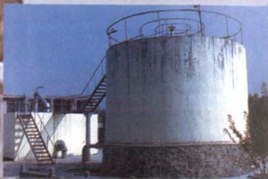
沱水自来水厂一角
