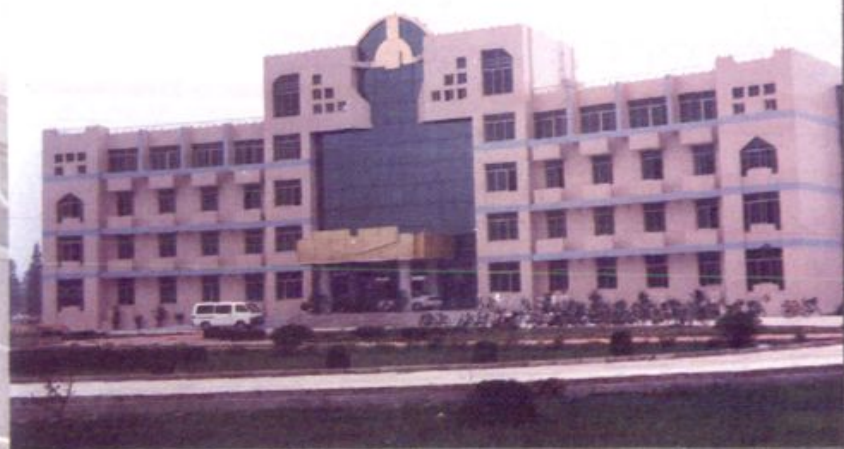
汜水镇人民政府办公楼
