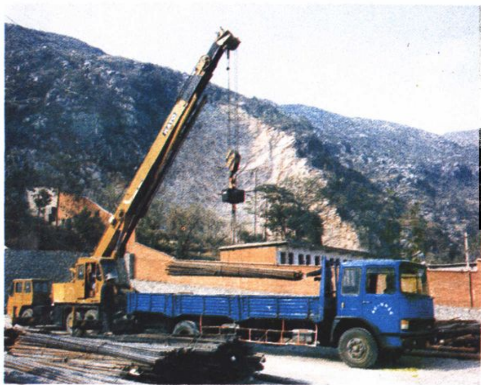
· 货场吊车作业情况
