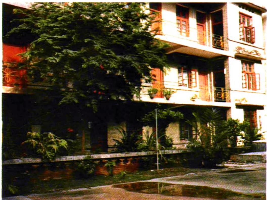
元江县粮食局办公楼
