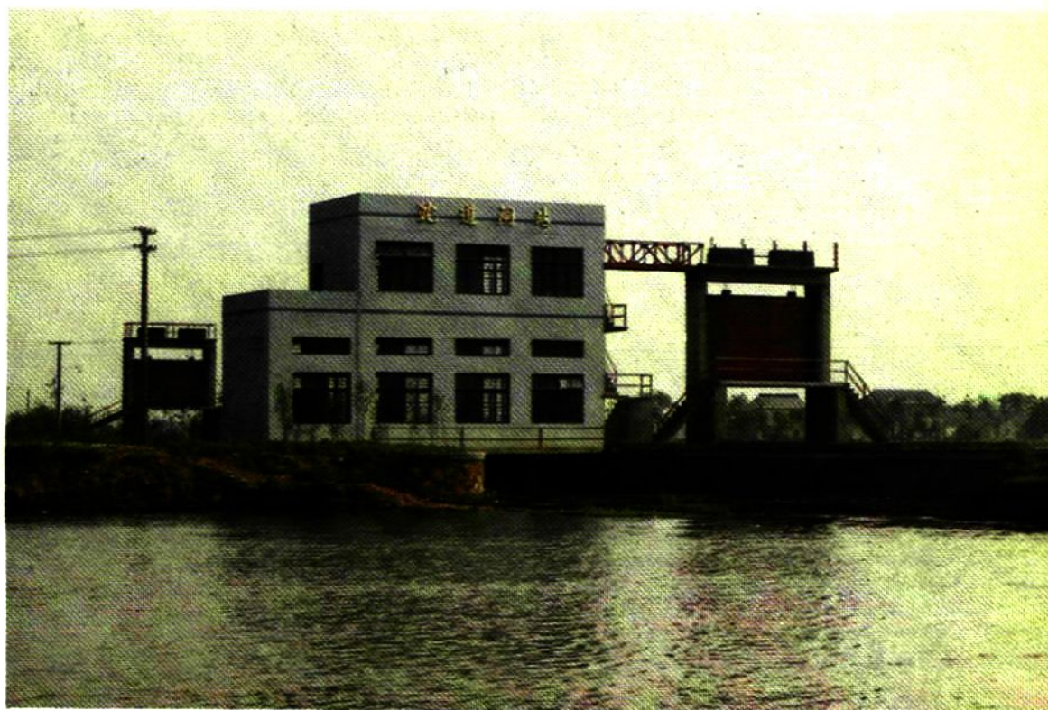
►一九九二年冬沈道圩区闸站建成
