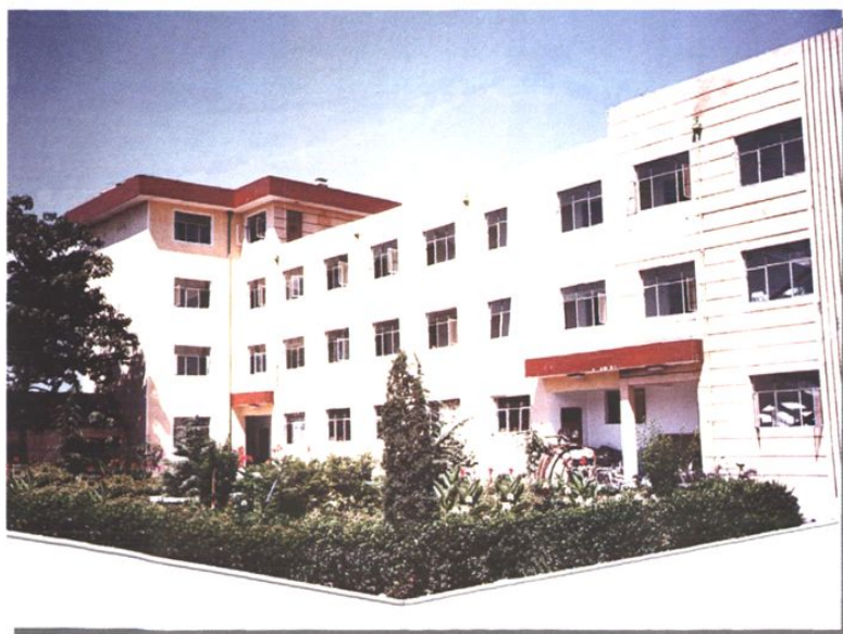
市中一建公司原办公楼 (1989)
