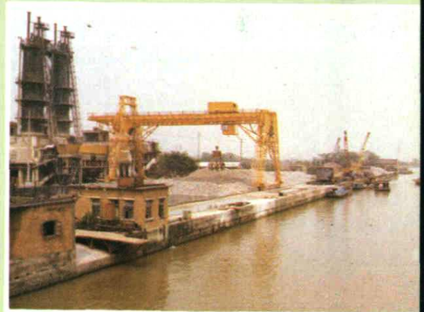
石灰车间一角
