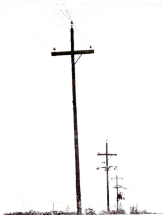
35千伏水泥杆输电线路
