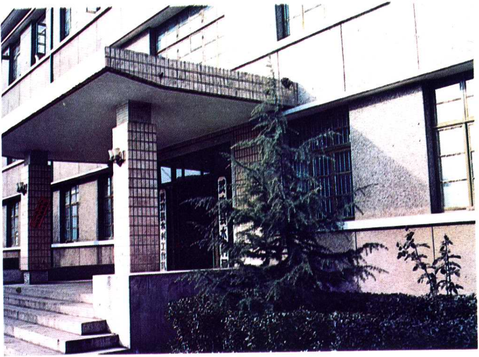
武功县水利局办公大楼
