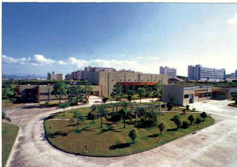
大涌转输泵站
