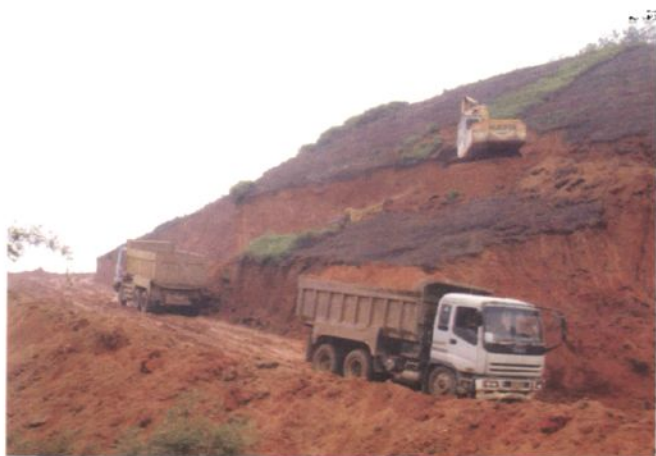
都杨佛转区挖土
