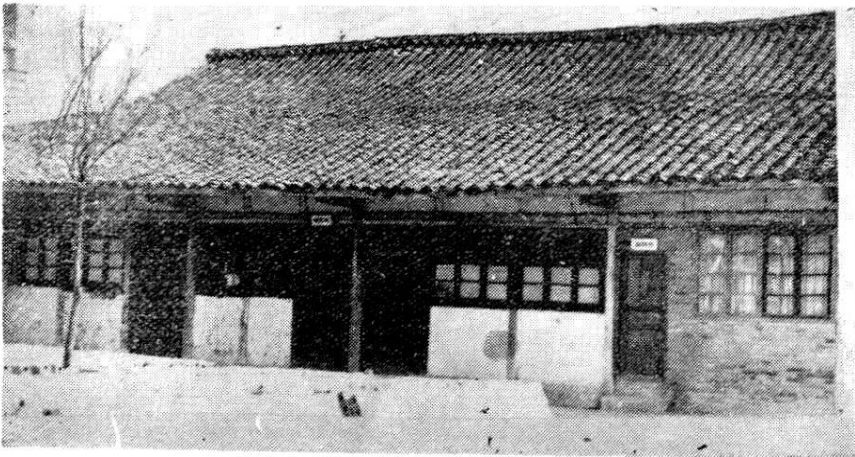
4. 原青川县司法处遗址（现青溪区公所干部宿舍）
