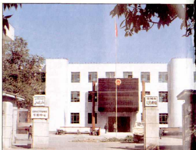
塔城市人民政府办公楼
