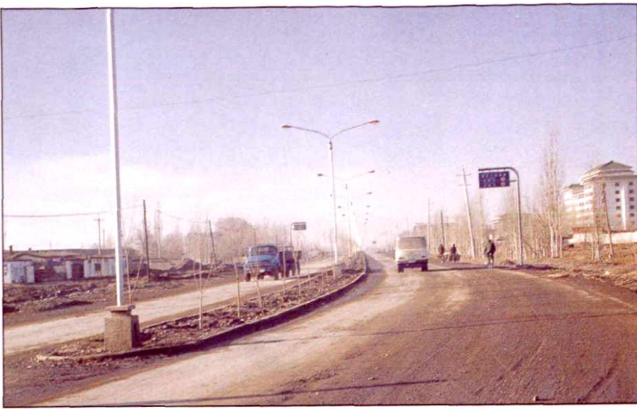
市区至巴克图 口岸二级公路
