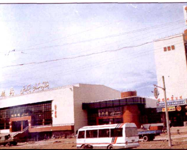
塔城国际客运站
