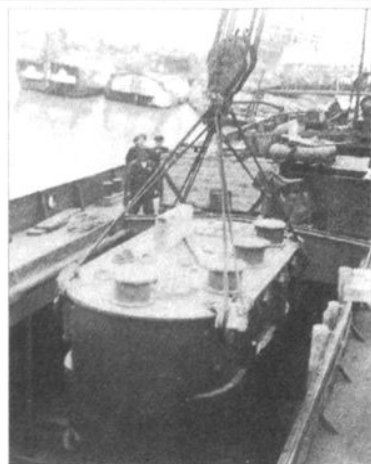
110千伏牛山变电所主变压器土法卸船起吊(1960年)
