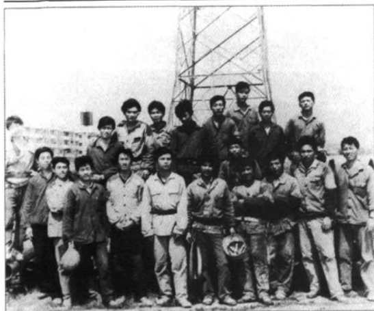
110千伏镇海至大碶输电线路高塔施工人员(1980年)
