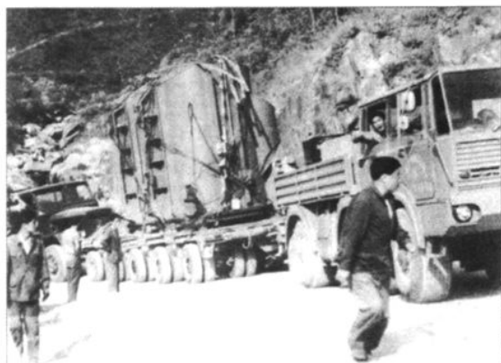
220 千伏临海变电所主变压器运输经过猫狸岭(1982 年)
