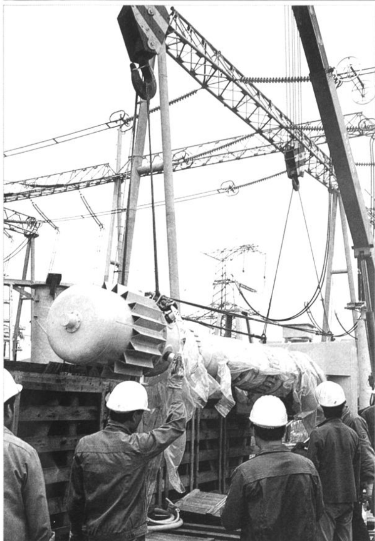
变电工吊装变电所设备
