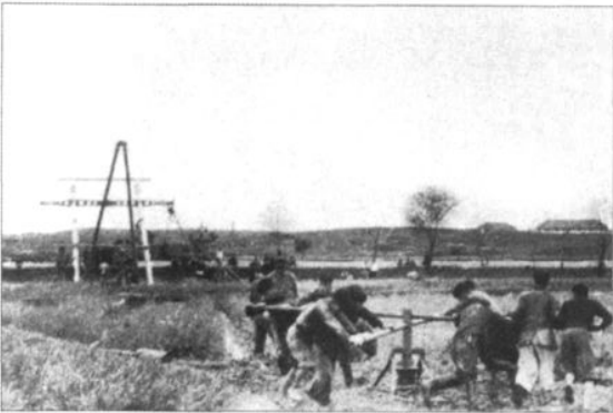
公司成立初期使用人推绞磨起吊水泥电杆(1958年)
