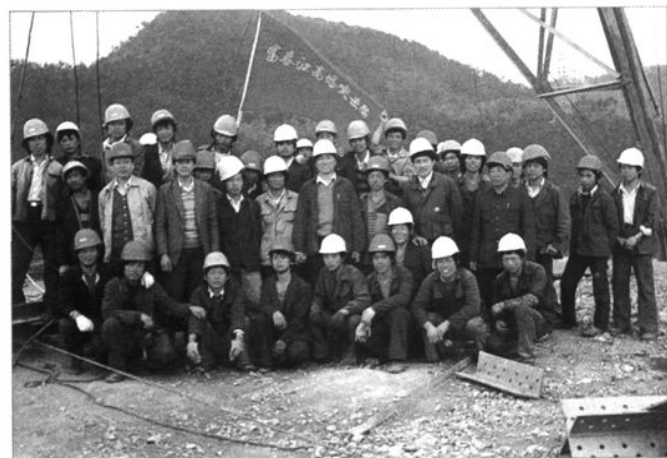
500千伏北瓶输电线路施工中的高塔突击队(1990年)
