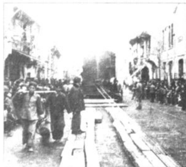
110千伏牛山变电所主变压器运输经过温州市区(1960年)
