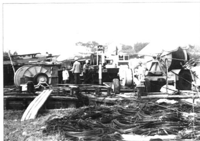
500千伏瓶窑至南桥输电线路水上架线作业(1987年)
