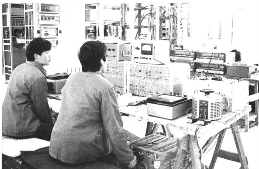
精心施工的变电调试人员
