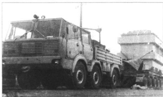
500 千伏瓶窑变电所主变压器在运输途中(1987 年)
