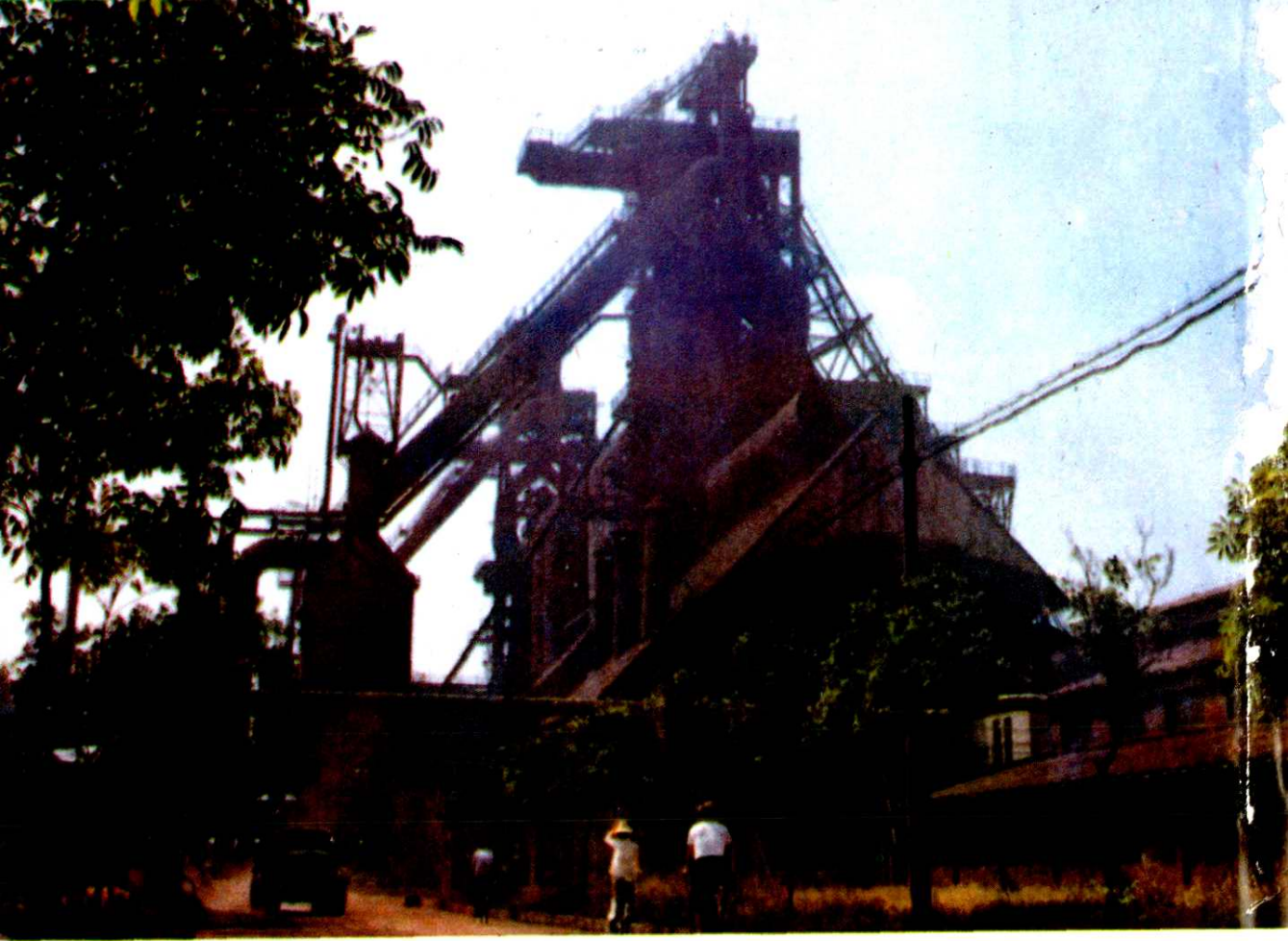
二号高炉、无钟炉顶、微机控制、高压操作。
