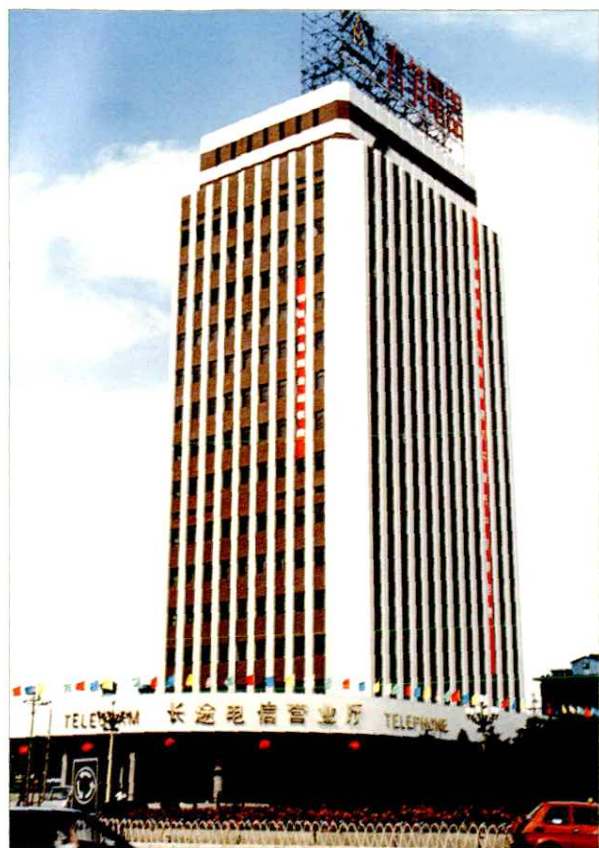
太原市电信枢纽大楼
