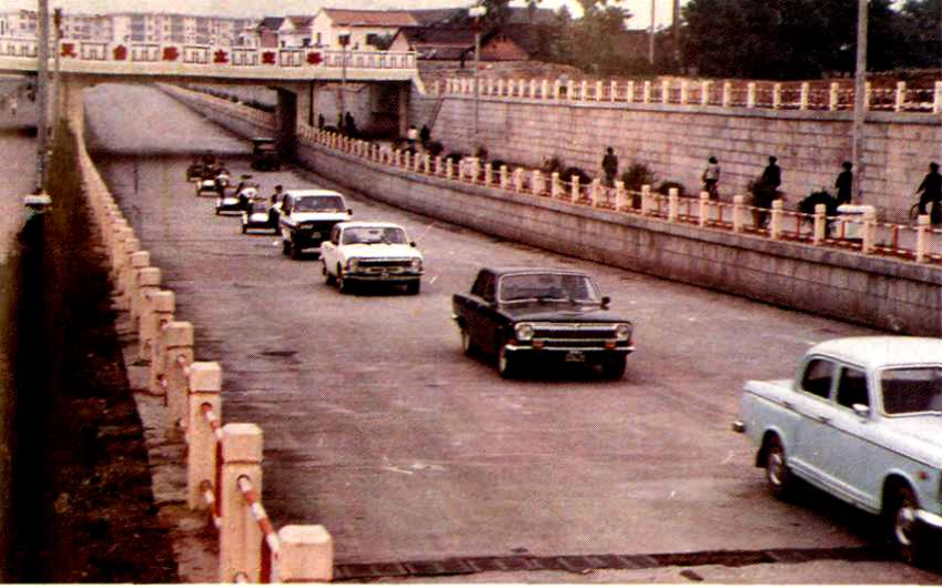
天台路立交桥
