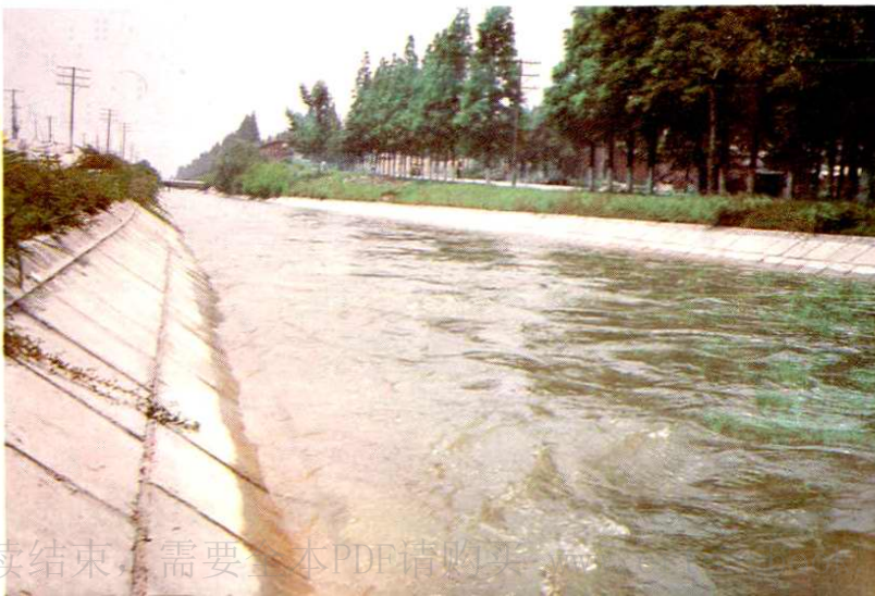
石门水库南干渠(原褒惠渠)
