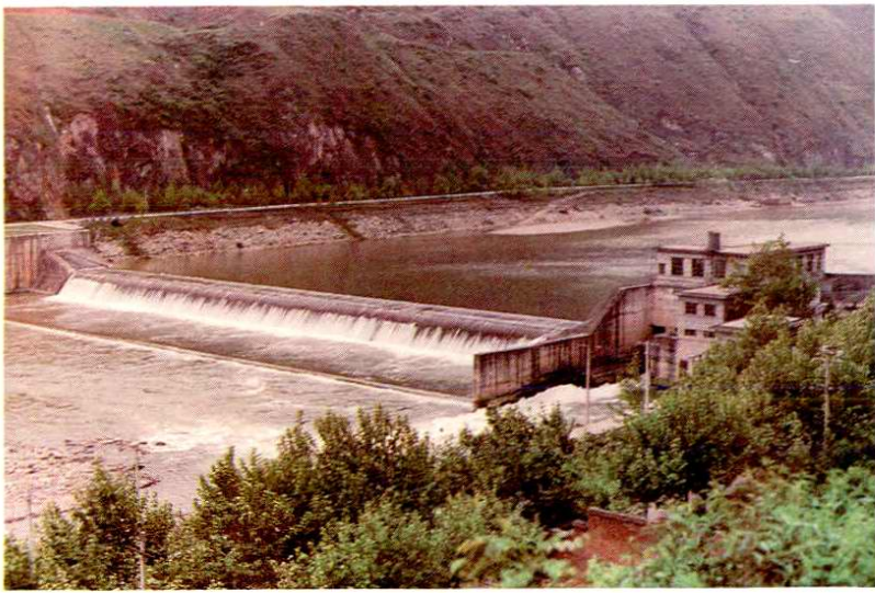
石门水库南渠(原褒惠渠)橡胶滚水坝
