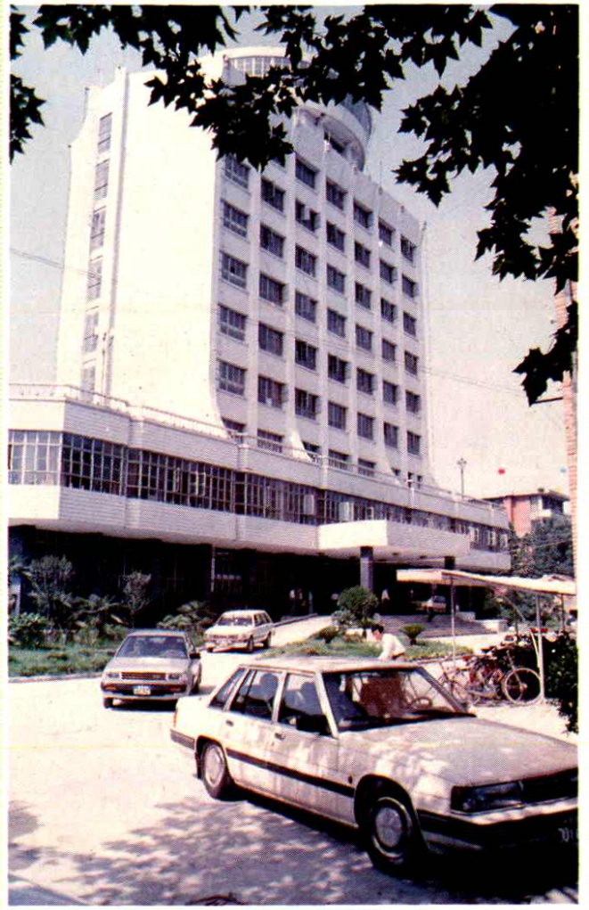
市人民政府大楼
