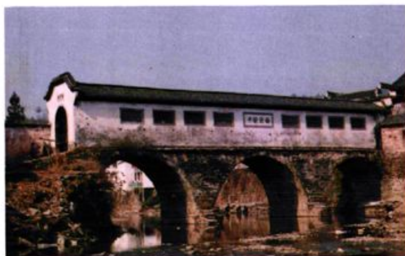
歙县北岸廊屋桥(明代)
