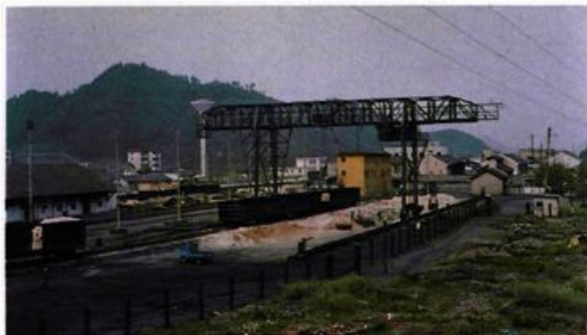
屯溪火车站货场龙门吊
