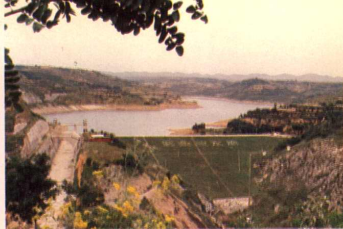
↑ 耀县桃曲坡水库
