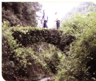
石门坑石拱桥(增坑村)，长13.5m，宽3m，清末建造。1959年修水库拆毁(石块用于修水库)。1964年村民筹资重建。摄于2016. 4. 28
