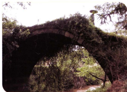
龙朱墩上石拱桥(新坑村)，清代建造。摄于2016. 4. 16
