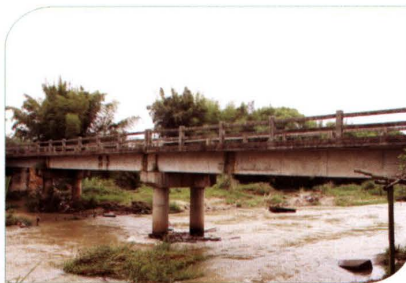
大姑桥。2009年建造，长56m，宽4.5m。 摄于2016. 4. 17
