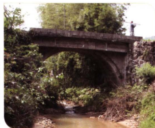
上油槽下石拱桥(西湖村)，清代建造。拱桥上方已浇水泥路供人车通行。摄于2016. 4. 28
