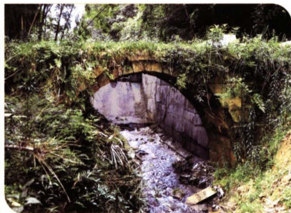
瓦屋下石拱桥(稿背村)。清道光年间建造。摄于2016. 5. 26
