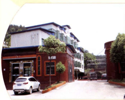
南康电力公司横市供电所。摄于2016. 4. 18
