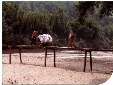
大姑人行木桥。现毁，改公路桥通行。摄于2005. 7. 11
