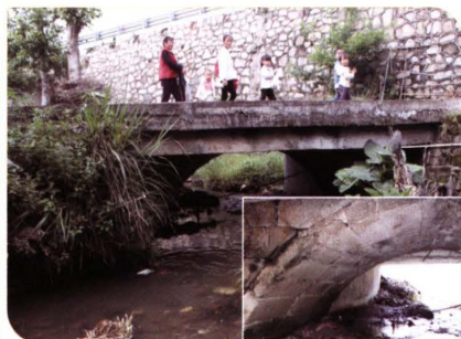
增坑口石拱桥。清代建造。拱桥上方已浇水泥路供人车通行。摄于2016. 4. 28
