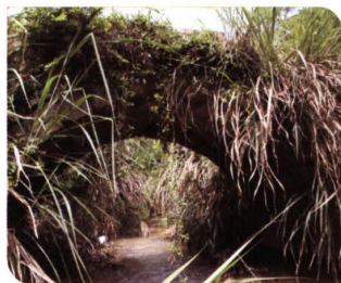
观音坵石拱桥(西湖村)，清代建造。摄于2016. 4. 28
