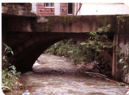
石角桥(长南村)。长4m，宽2.5m。清光绪年间建造。拱桥上方已浇水泥路供人车通行。摄于2016. 4. 18
