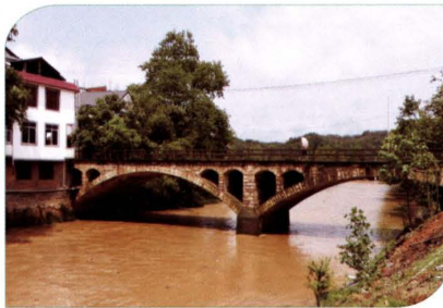
沙莞桥。1973年建造，长57.6m，宽7m。 摄于2016. 4. 16雨后洪水
