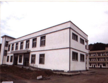
横市农村公路综合服务站(建设中)综合服务楼。摄于2016. 4. 19
