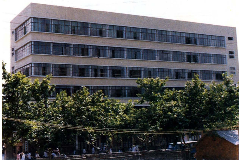
新落成的调度大楼
