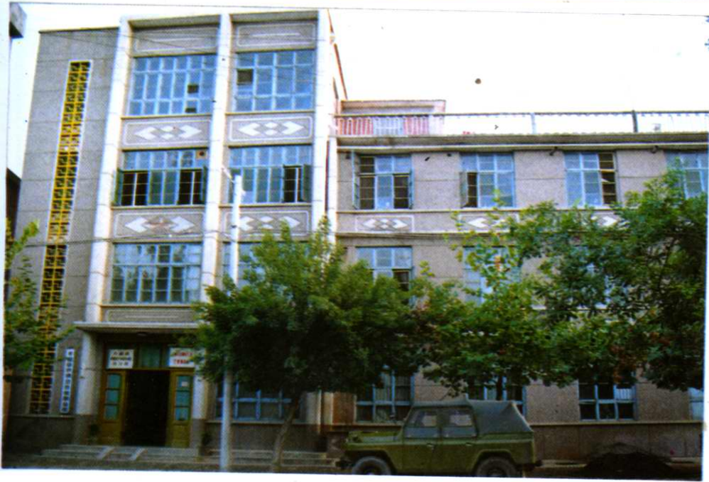
千阳县供销社办公楼
