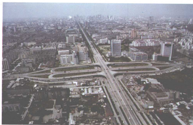
二环路人民南路立交桥
