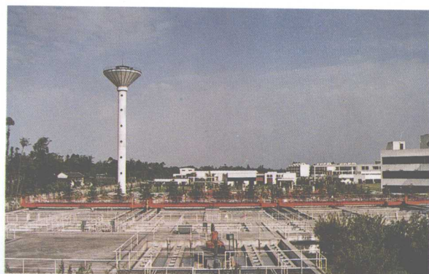
成都自来水六厂 净化工艺池
