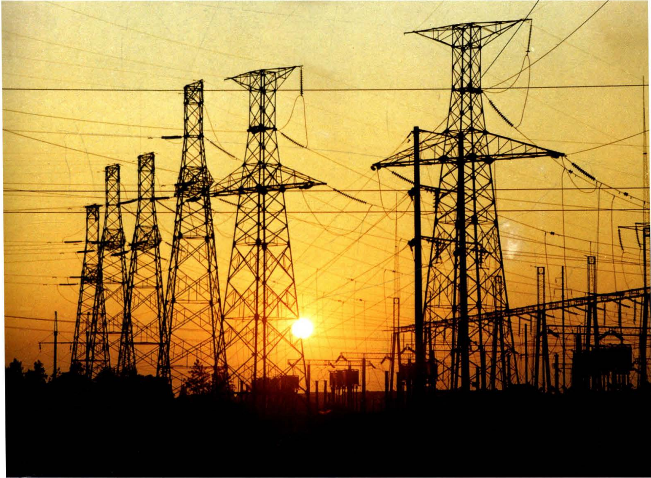
1970年投运的220千伏泰州变电所进出线路雄姿
