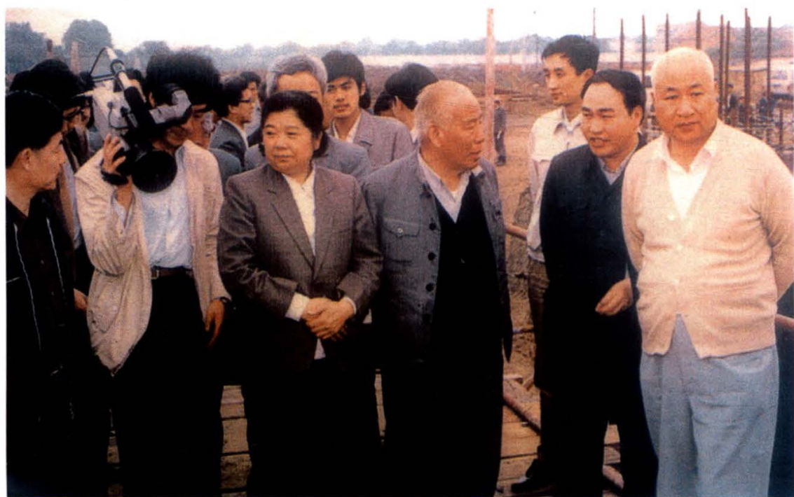
1987年5月22日，江苏省省长顾秀莲和电力部副部长王林察看新海发电厂扩建工程
