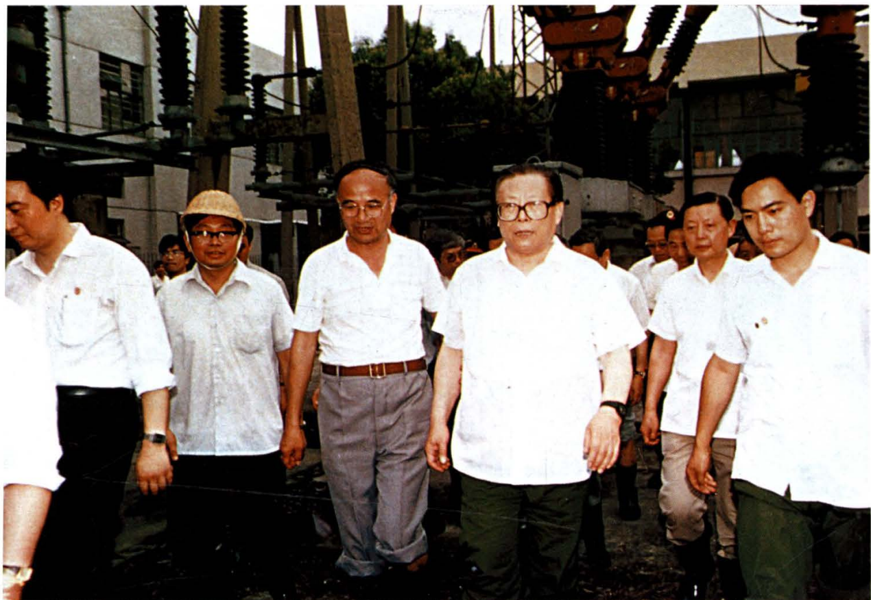
1991年7月9日，江泽民总书记视察苏州供电局胥门变电所水灾情况
