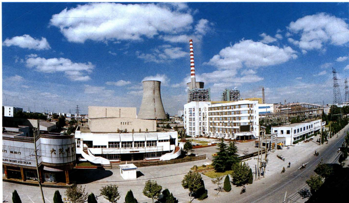
1991年9月，装机45万千瓦的新海发电厂
