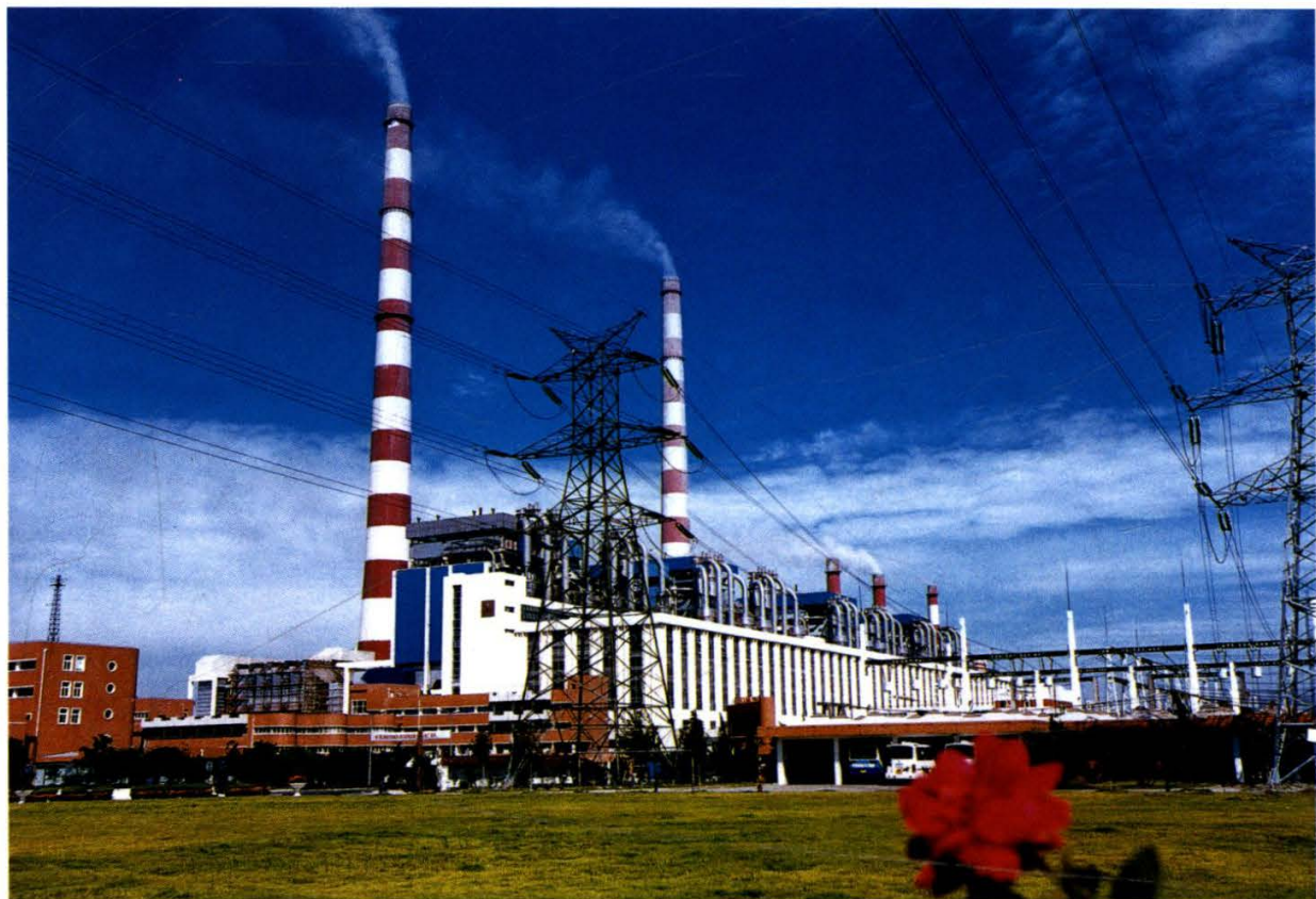
1987年9月，装机162.5万千瓦的谏壁发电厂
