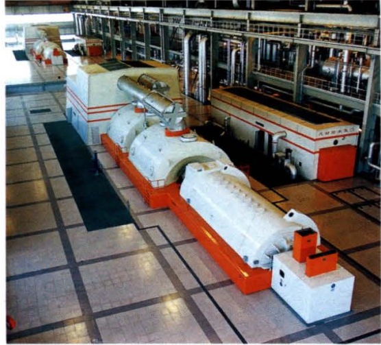
扬州第二发电厂2台60万千瓦汽轮发电机组
