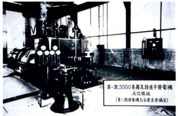
1933年首都电厂下关发电所安装第一台德国西门子5000千瓦汽轮发电机组投产
