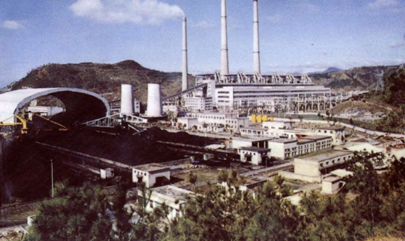
台州发电厂全景
