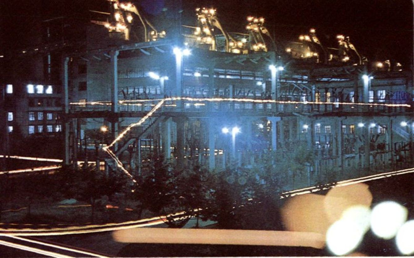
220 千伏升压站夜景
