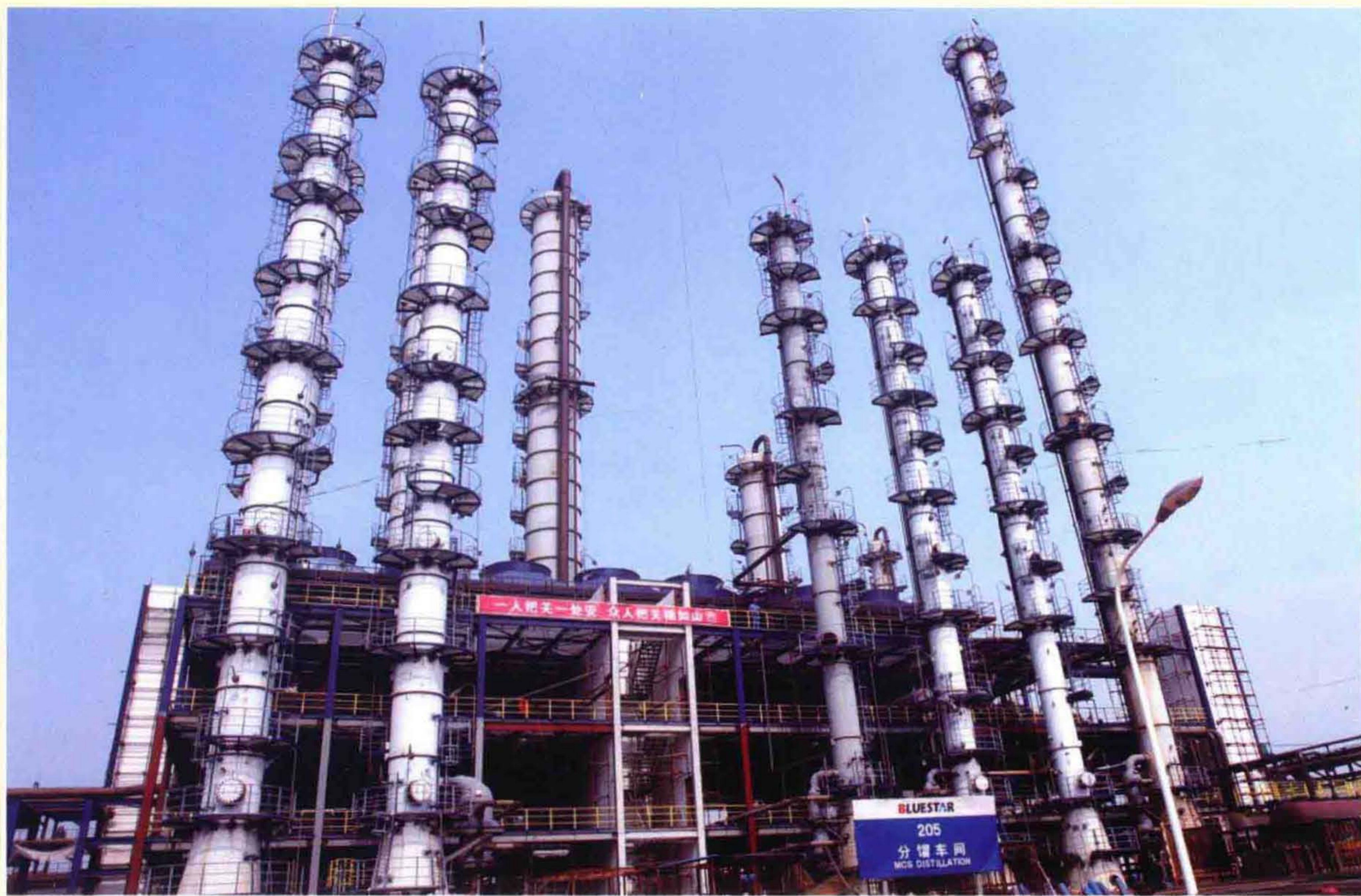
星火厂 20 万吨有机硅分馏车间
