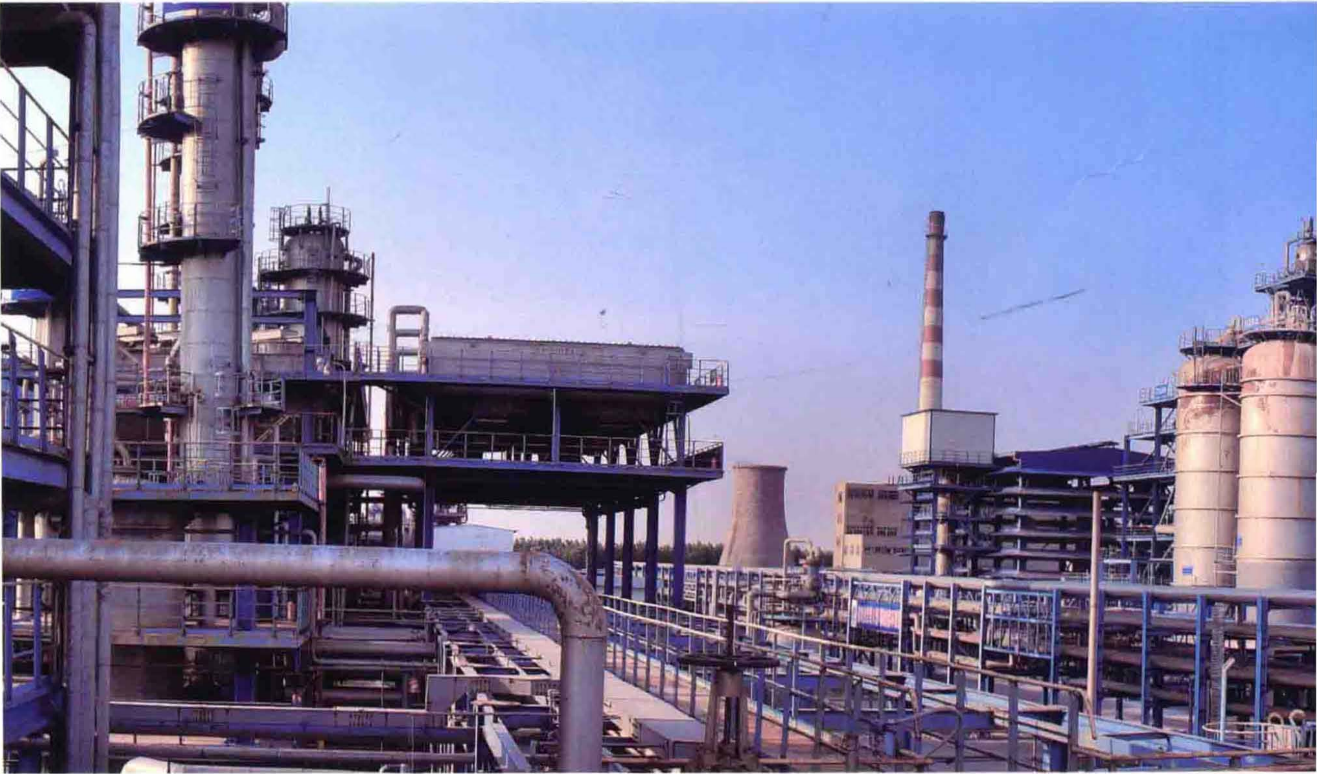
正和石化 DCC 联合生产装置
