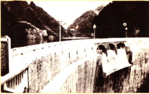
贵州汞矿三废治理工程，大水溪尾矿大坝
