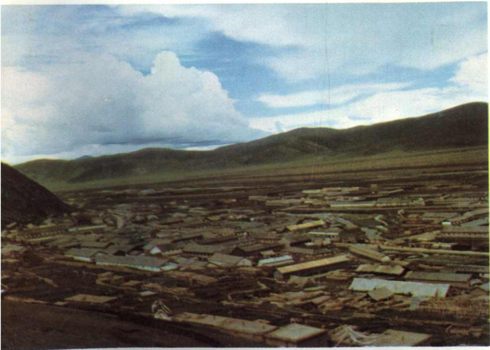
石渠县城一角
