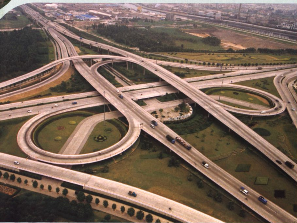
▲ 桂江立交桥，位于桂城海八路，是一座苜蓿叶加定向组合式城市型完全互通式立交桥。桥长1851.37米，由三层19座桥梁组成。工程占地171333平方米，总投资约1.7亿元，于1997年9月23日竣工通车。
