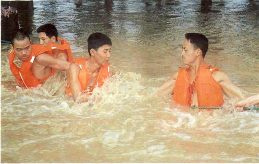
8月17日,某部四营官兵下水勘察荆江大堤铁牛矶险情。
