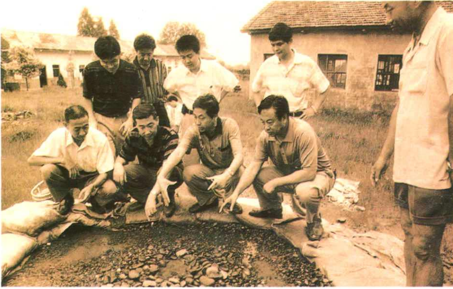
区委、区政府、区政协领导研究处理边江村重大管涌险情。
