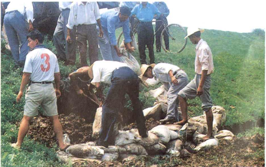
马家寨乡耀兴民堤8月19日抢险场面。
