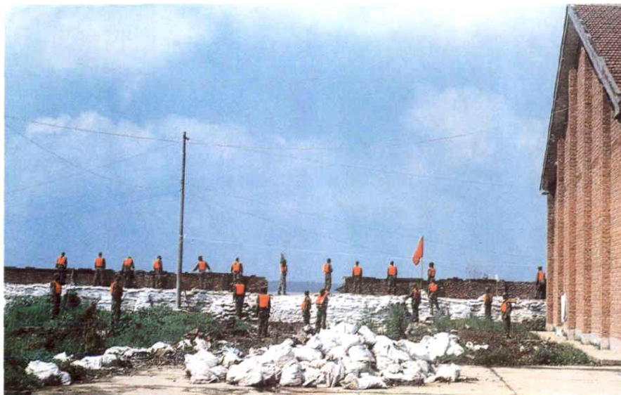
荆江大堤外滩国家粮库段面出现重大险情。图为险情控制后的场面。
