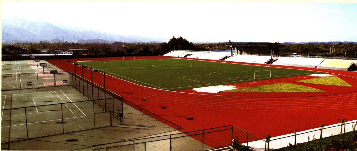
塑胶运动场（2010年8月竣工）
