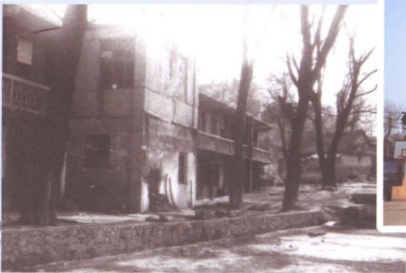
钟山区一小老教学楼
