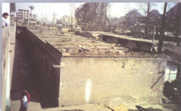
钟山区五中老实验楼
