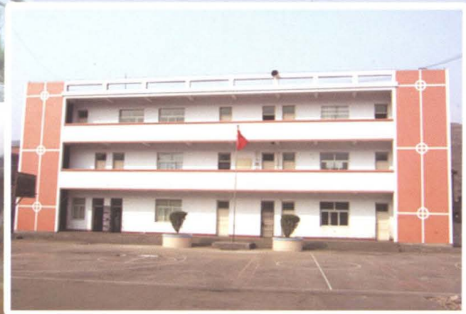
小湾村小学新教学楼
