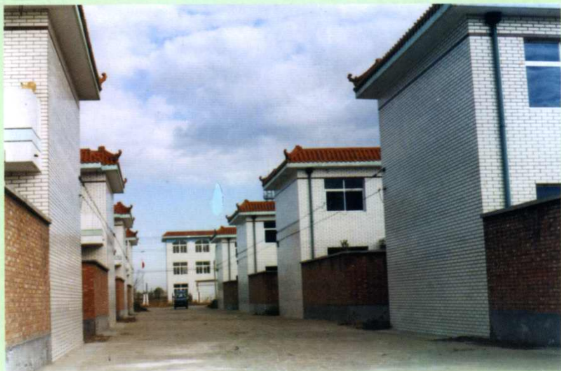
南王平镇生活小区住宅楼
