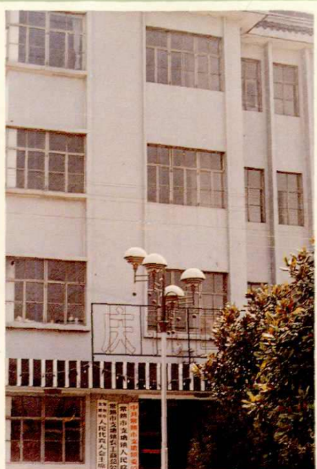
◀支塘镇政府办公大楼
