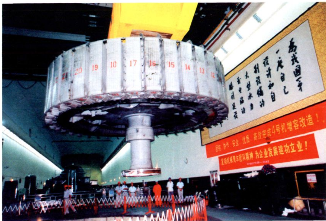
1997年10月增容改造4号机组，施工中起吊发电机转子
