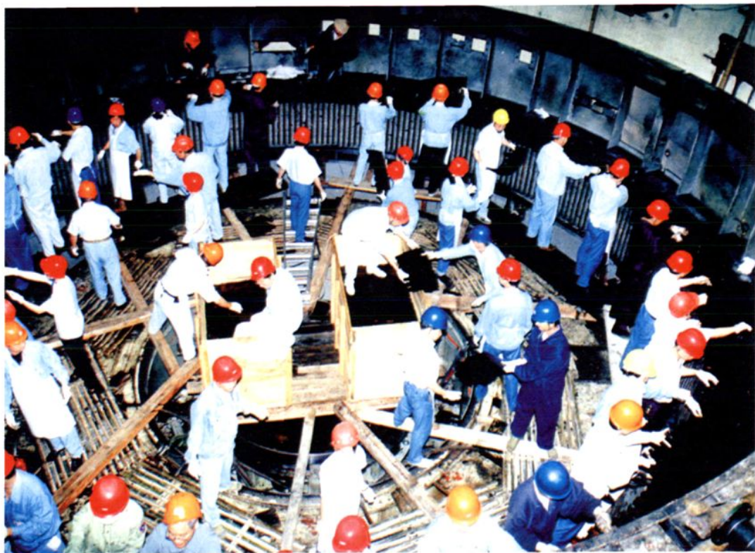
拆卸发电机定子矽钢片
