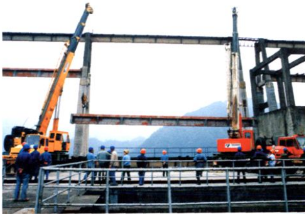
加固改造坝顶变压器出线支架A字梁
