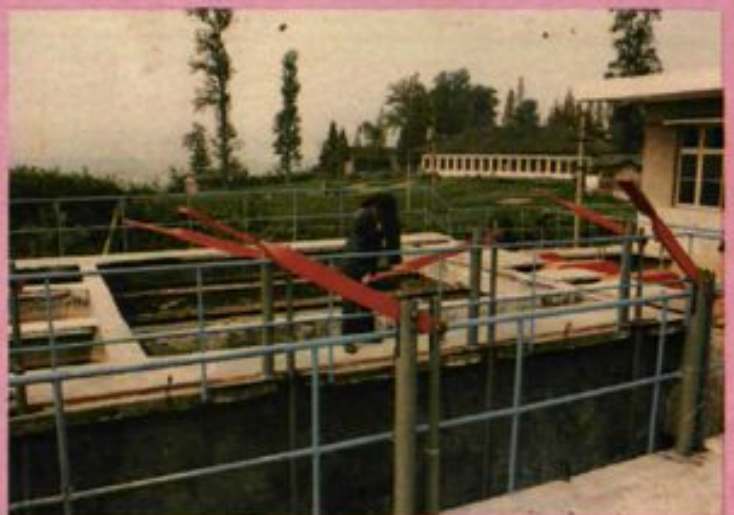
来凤县自来水厂净化车间
