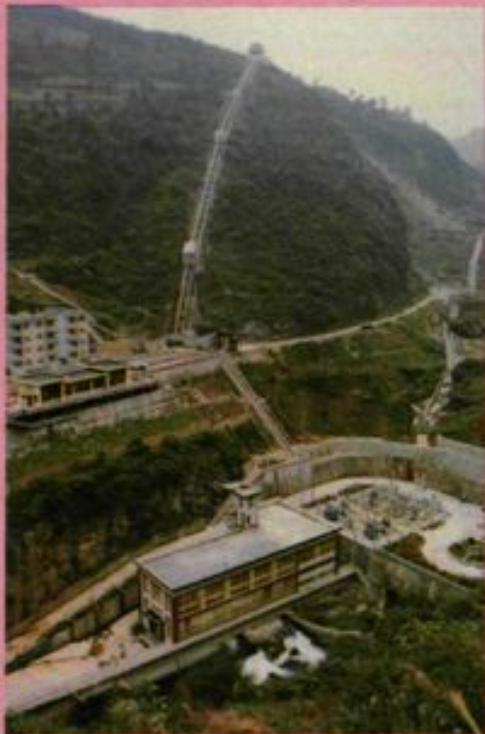
咸丰县丁寨水电站
