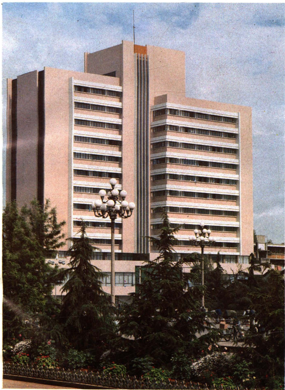
云南科技文化大楼 近年来，昆明市区内一幢幢高层建筑拔地而起，云南科技文化大楼是其中的一座
