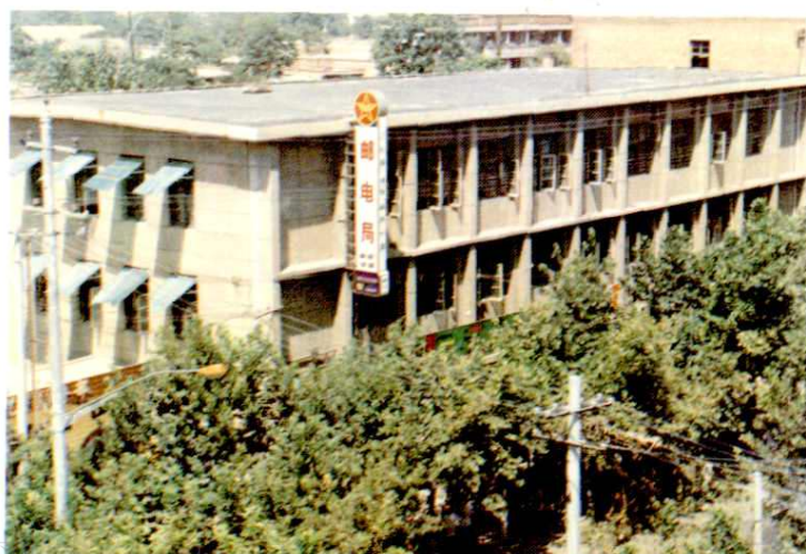
1973年10月落成的东风街邮电楼
