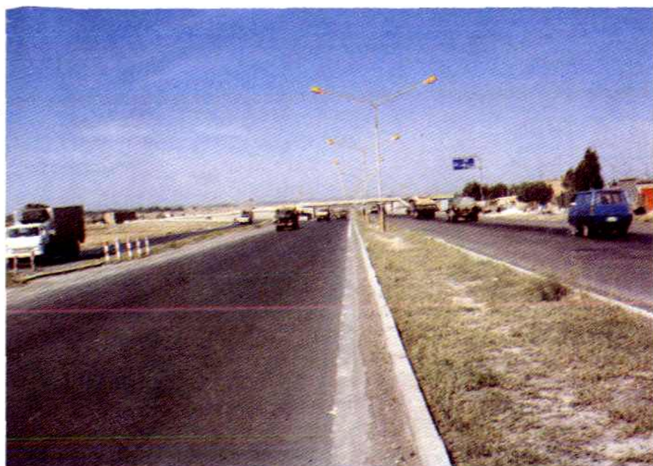
乌鲁木齐西出口一级公路
